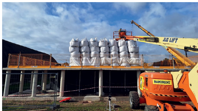
Pilna mēroga šķiedrbetona plātnes eksperimentālā slogošanas Paula Lejiņa ielā 2, Jelgavā sadarbībā ar SIA Primekss (2023)
