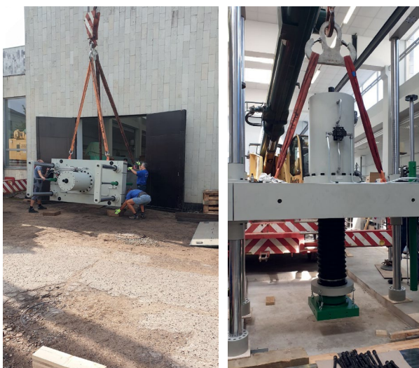
Jaunās Form+Test iekārtas Alpha 10-3000 uzstādīšanas process (avots: Mārtiņš Priedītis)
