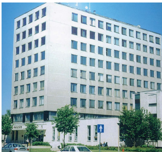
HMF ēka Puškina prospektā (tagad Akadēmijas) ielā 19.
