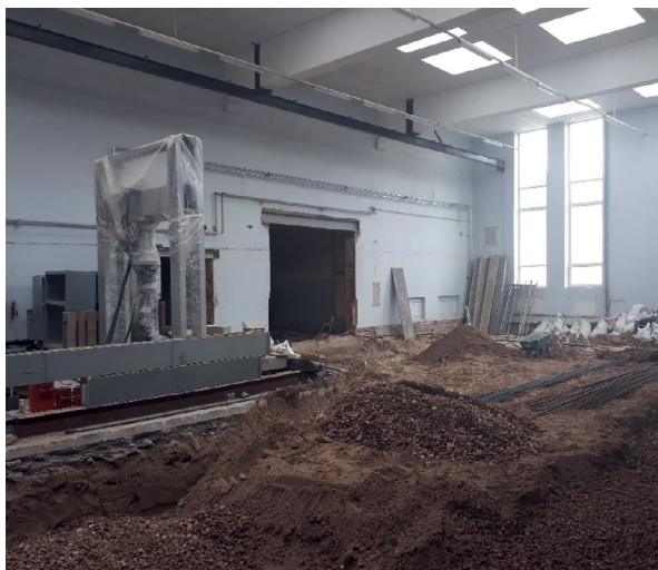
Reverberācijas kameras izbūves process
