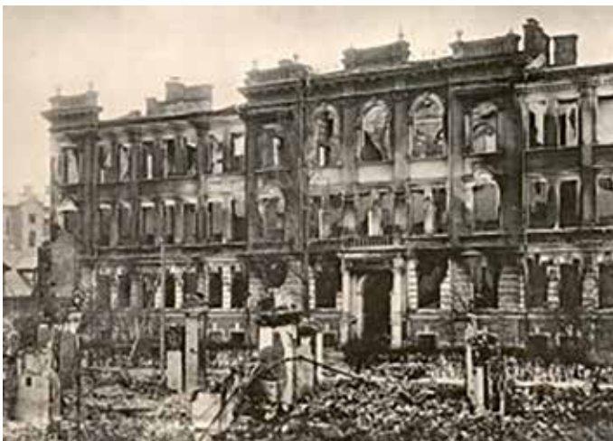
Bermontiādes laikā nodedzinātā Jelgavas reālskolas ēka 1919. gadā
