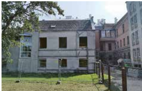
Fakultātes ēka ar mazo piebūvi pirms renovācijas darbiem un piebūves nojaukšanas 2022. gada aprīlī
